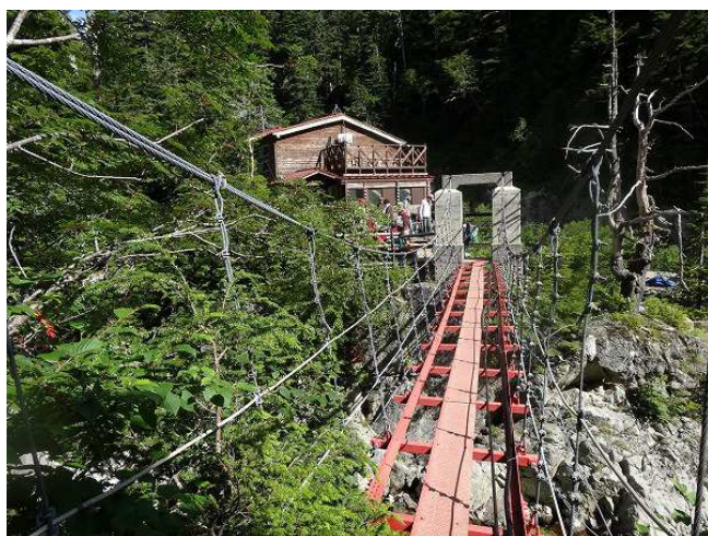
赤い吊り橋と薬師沢小屋
