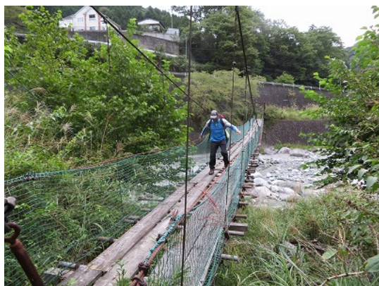
河内川吊り橋
