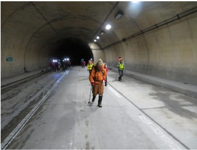
釜トンネル内
