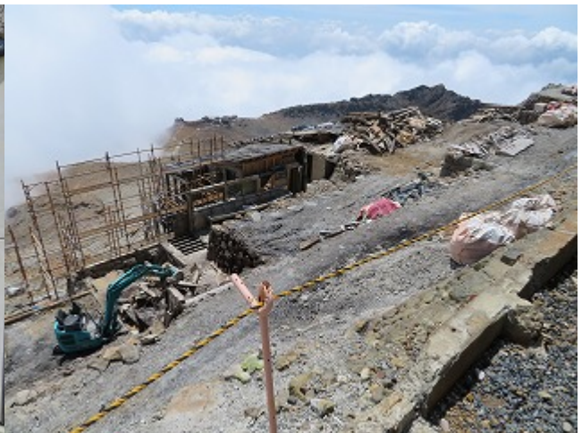
再建中の頂上小屋
