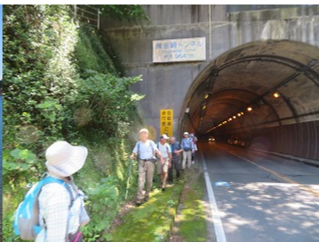
黄金崎トンネル
