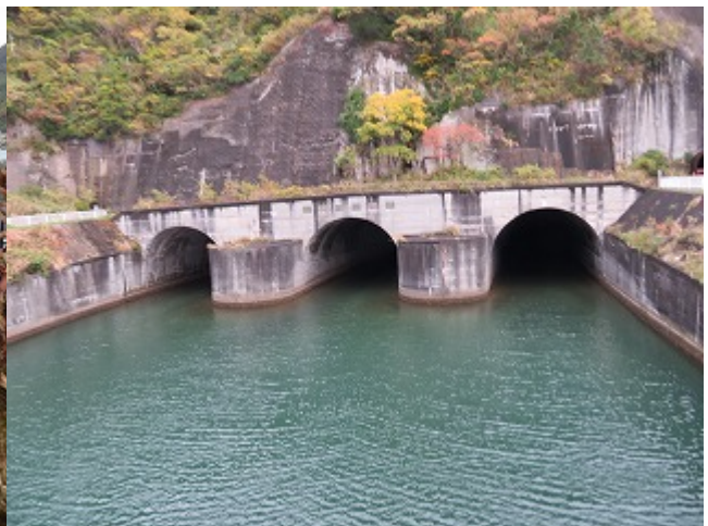
狩野川放水路
