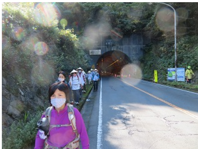
黄金崎トンネル
