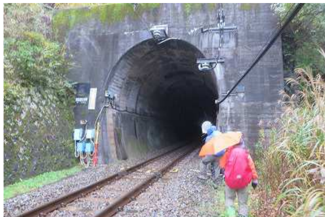
御殿場線トンネル
