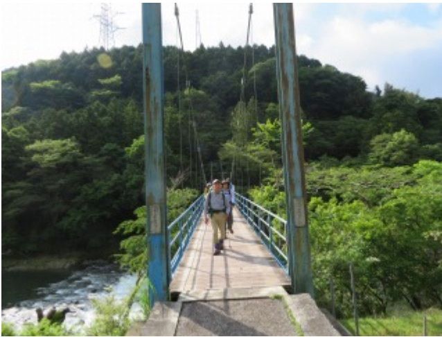
河内川吊り橋
