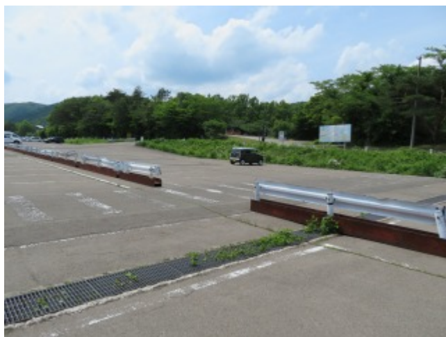
泉ヶ岳駐車場
