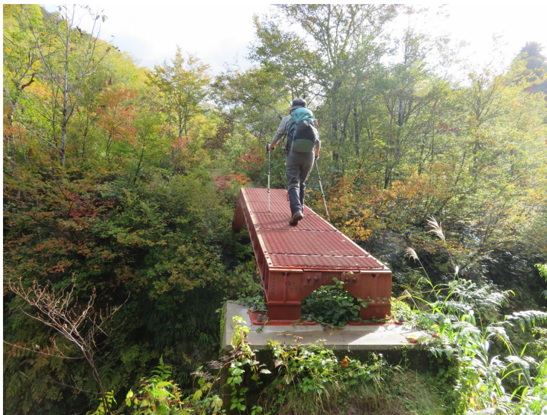
向うが見えない、手摺が無い「への字」橋
