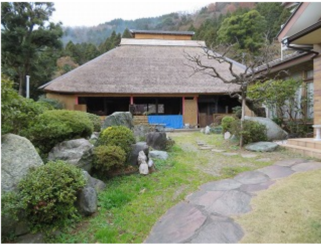
工事中の茅葺民家
