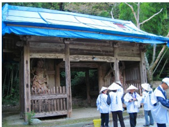
補修中の山門
