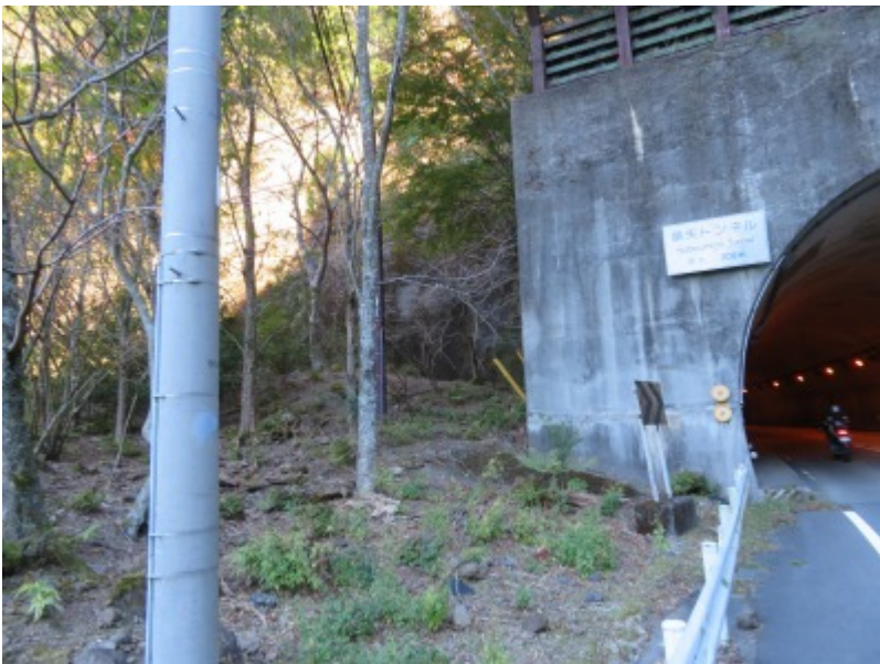
鍋失トンネル南
